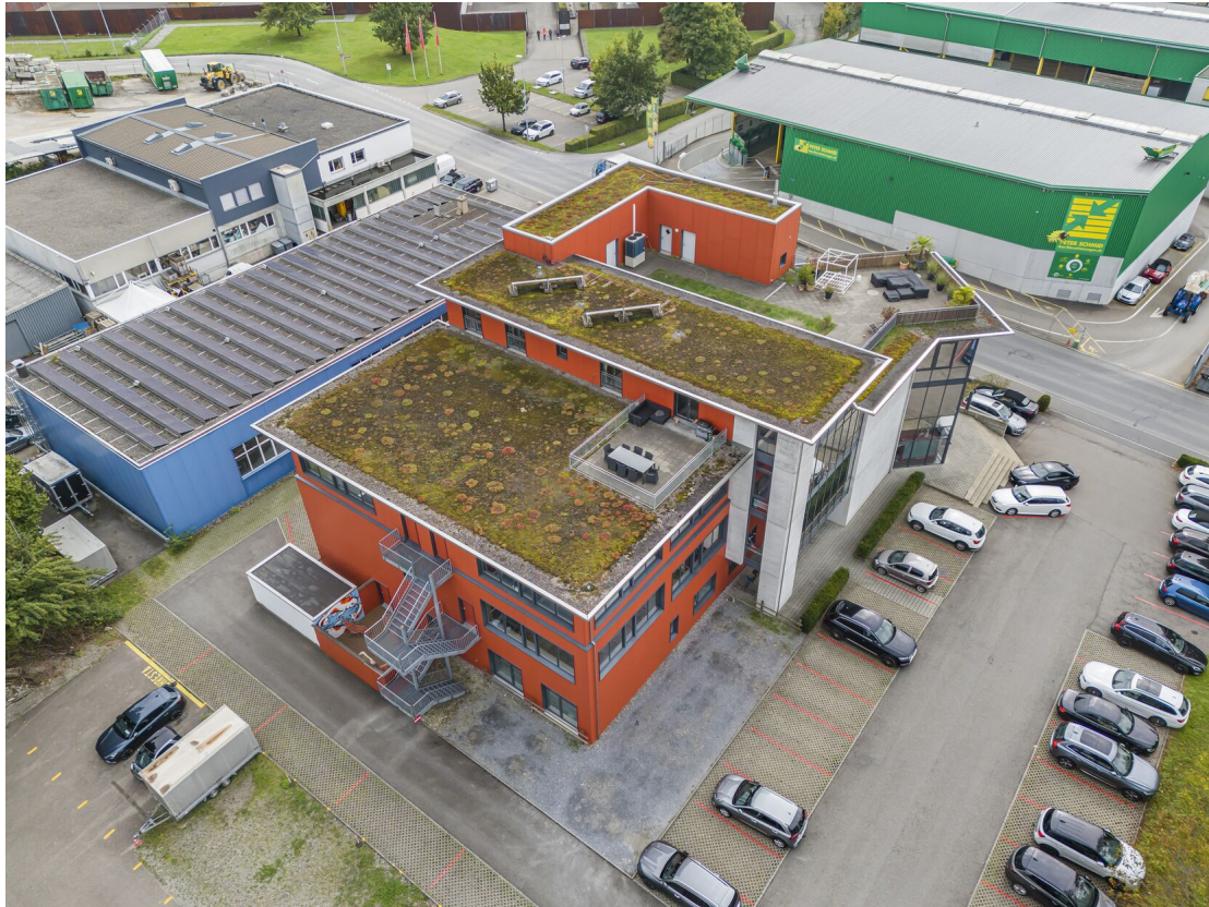
Gebäude inkl. Parkplätze
