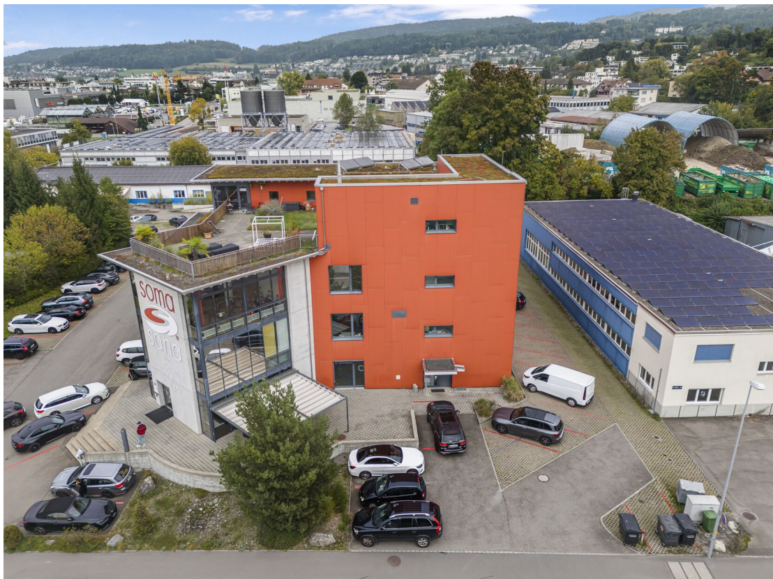
Gebäude inkl. Parkplätze
